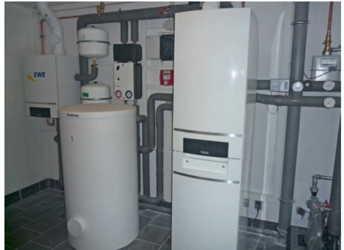
Gaswärmepumpen im Alltagstest: Diesen Neubau versorgt eine Buderus-Anlage mit Heizwärme und Warmwasser.
