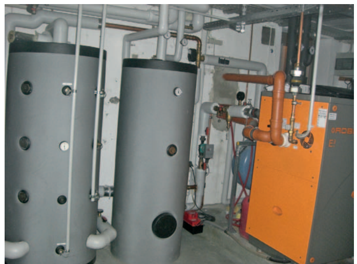
Stand Ende 2010 waren europaweit bereits über 5000 Robur-Gas-Absorptions-Wärmepumpen im Einsatz. Beim EWE-Feldtest geht es nicht zuletzt um die Anpassung der 20-kW-Anlagen an die Bedingungen in einem Einfamilienhaus.
