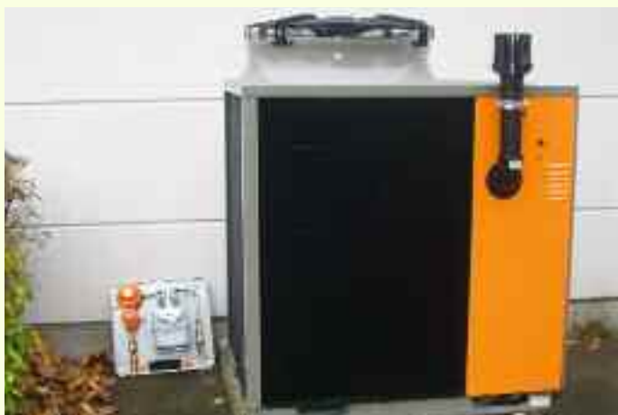
Die mit Flüssiggas betriebene Wärmepumpe versorgt sämtliche Gebäude des Regionalzentrums mit Wärme.
